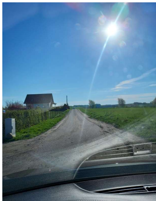
Zdj. 21 Stawowa po modernizacji
