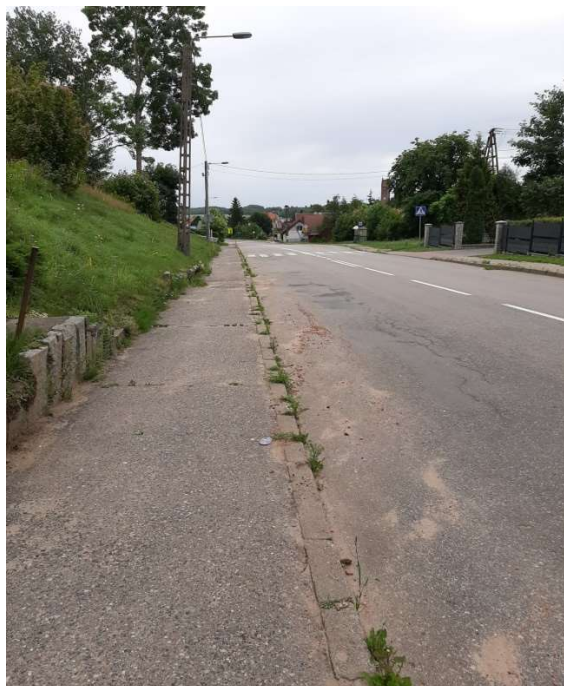
Zdj. 30 Ul. Elbląska przed przebudową
