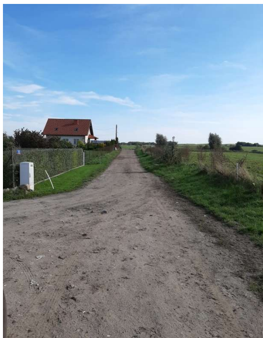
Zdj. 20 Stawowa przed modernizacją
