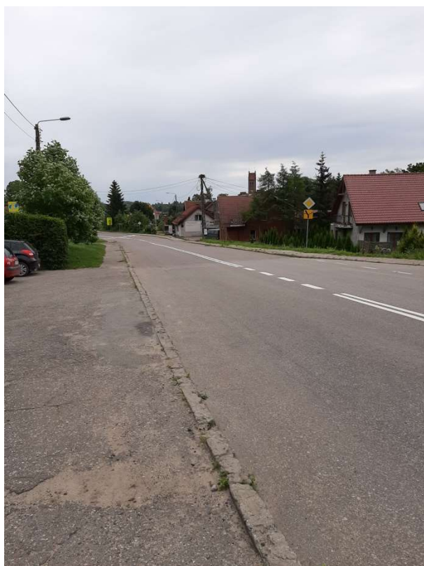
Zdj. 34 Ul. Elbląska przed przebudową
