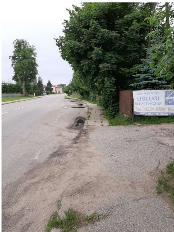
Zdj. 32 Ul. Elbląska przed przebudową
