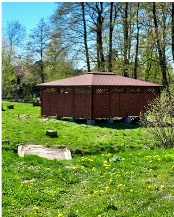
Zdj. 15 Nowa wiata rekreacyjna w Kamienniku Wielkim
