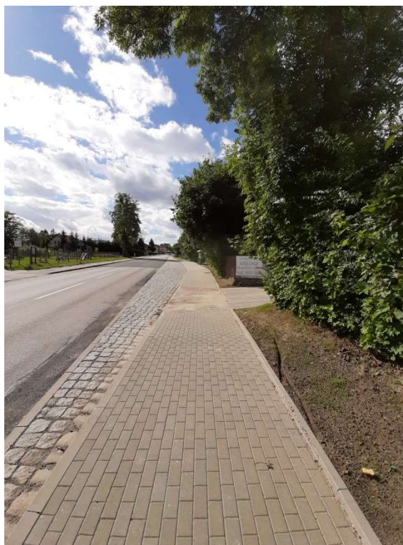
Zdj. 33 Ul. Elbląska po przebudowie
