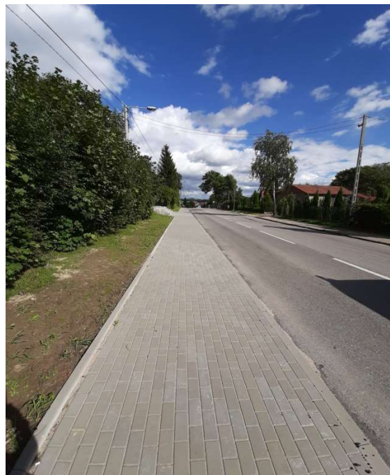
Zdj. 31 Ul. Elbląska po przebudowie
