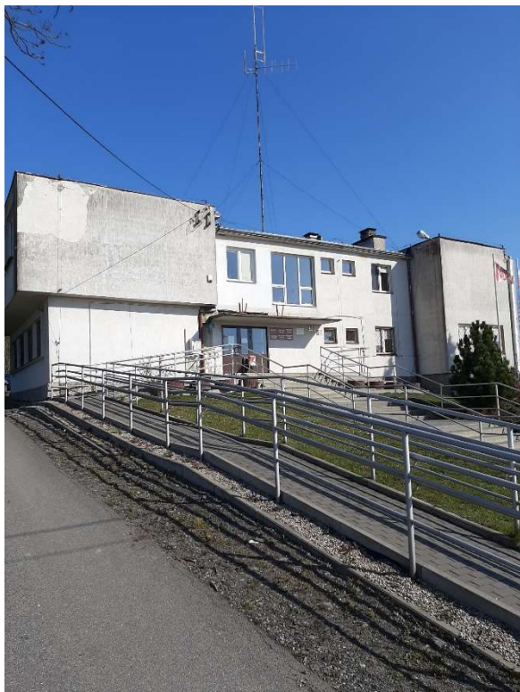
Zdj. 2 Stan przed termomodernizacją
