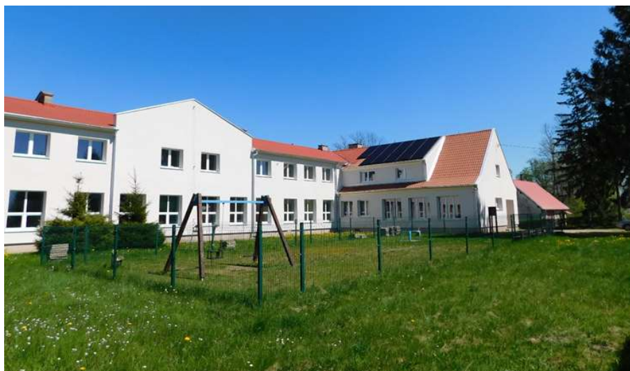
Zdj. 7 Pomorska Wieś 40 po termomodernizacji
