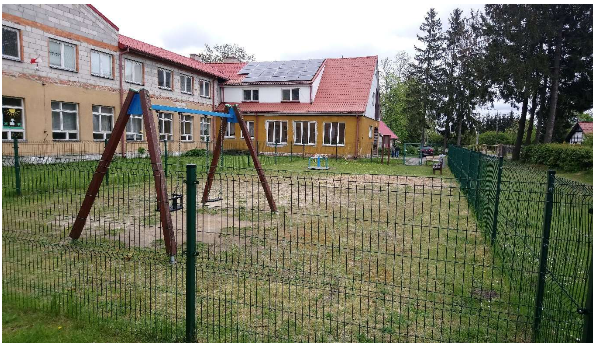
Zdj. 6 Pomorska 40 przed termomodernizacją
