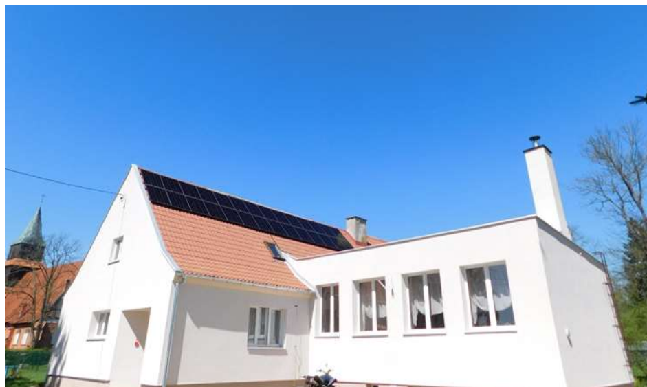
Zdj. 9 Pomorska Wieś 40 po termomodernizacji
